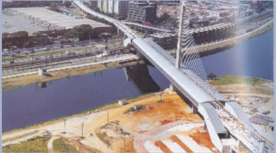
Figura 10: Puente arriostrado sobre el Río Pinheiros en San Pablo (Brasil)
