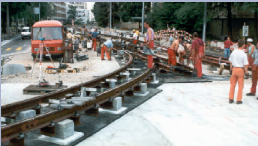
Figura 12: Sistema masa-muelle liviano con esteras de vía permanente USM® en las vías en calles
