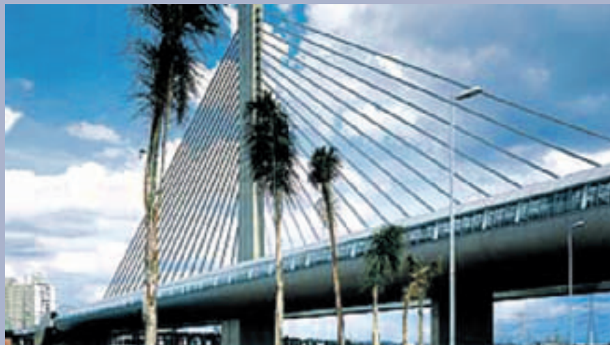
Figura 9: Vía elevada con estereras de vía permanente USM® instaladas
