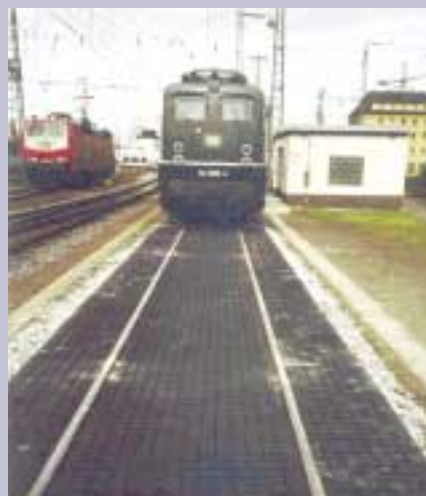
OIL-EX® sobre un local de estacionamiento de locomotoras
