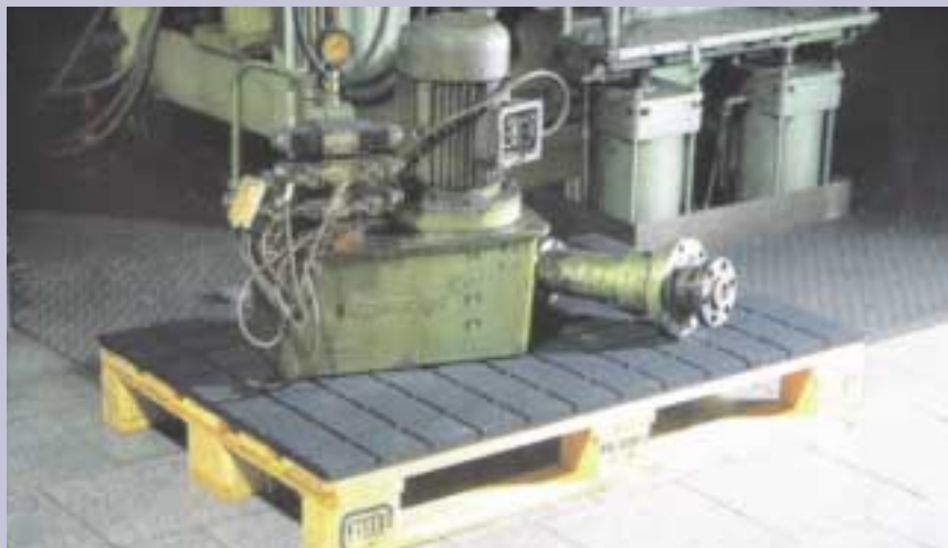
Colocación de apoyos intermedios debajo de agregados
