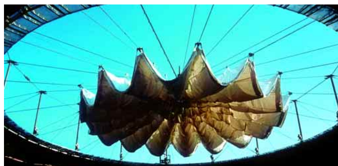
Cubierta interior durante la operación de retracción
