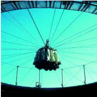
Cubierta interior abierta Inner roof, open
